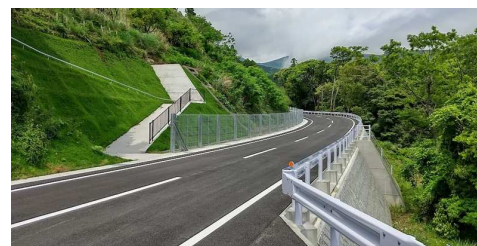
全線開通へ向け整備が進む「湯ヶ岡=赤川線」。まだまだ長い道のり…。
