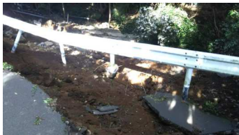
湯ヶ岡赤川線の崩落現場。今回の土砂災害は太陽光発電の開発が疑われるケースがありました。ソーラーパネルが吹き飛ばされる被害も多数発生し、異常気象の下での自然エネルギー開発の是非が問われます。
