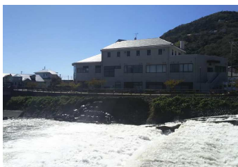
台風15号の被害で福祉センターの側道が陥没しました。県はえぐられた護岸を土のうを施しましたが19号で被害は拡大しています。
